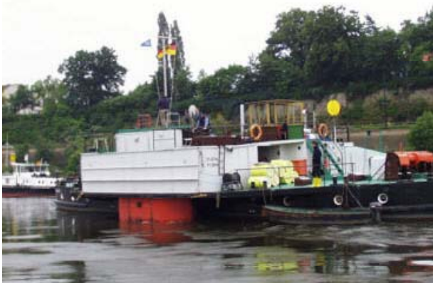
Abb. 11: Einsatz des Taucherschachtes mit angehobenem Schacht (links) und mit abgesecktem Schacht (rechts) in Dresden
