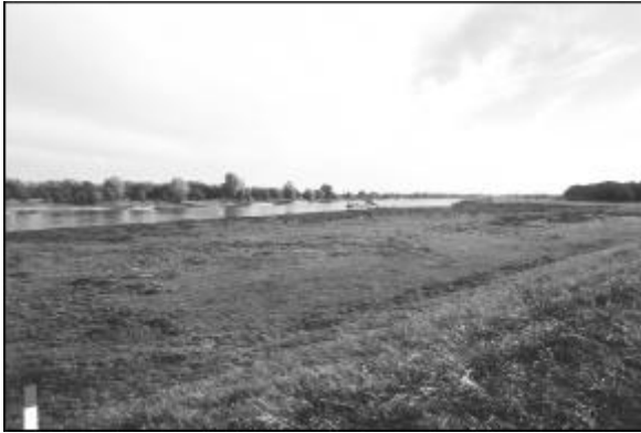
Barbyer Elbauen südlich der Eisenbahnbrücke (Ri. Süden)
