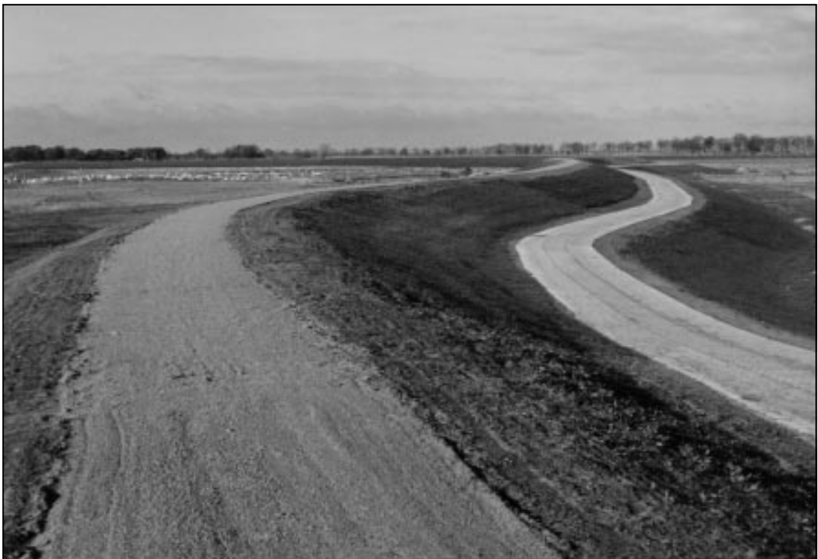
Foto 6: Ertüchtigter Deich mit Radweg und Berme
