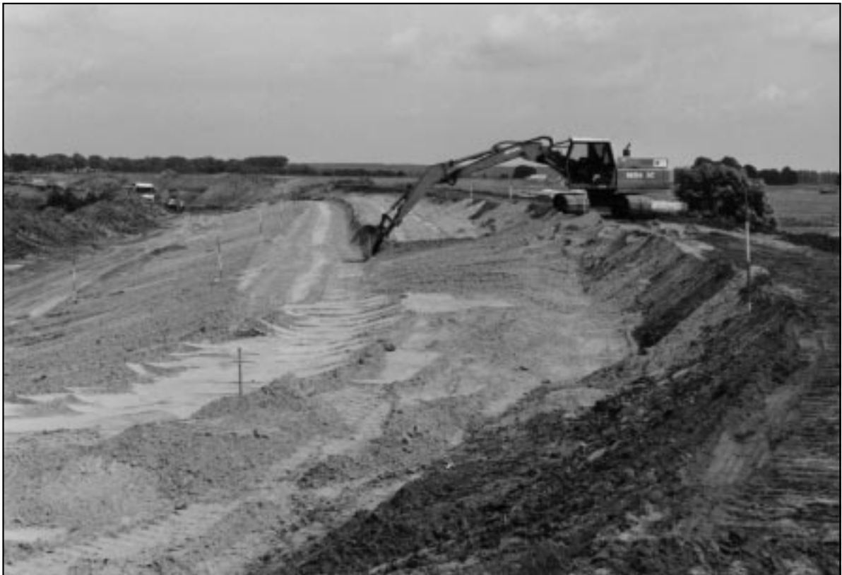
Foto 5: Ertüchtigung des Altdeiches durch Auffüllung mit Sand
