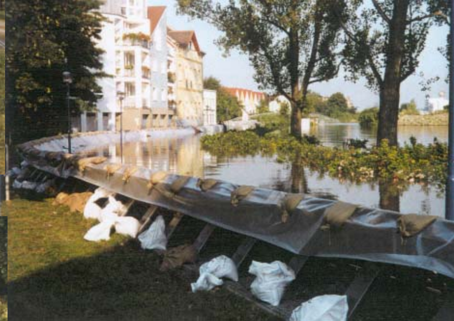
Mobile Hochwasserschutzwand aus Köln der Stadtlage Schönebeck am 19.08.2002 bei Durchgang des Hochwasserscheitels
