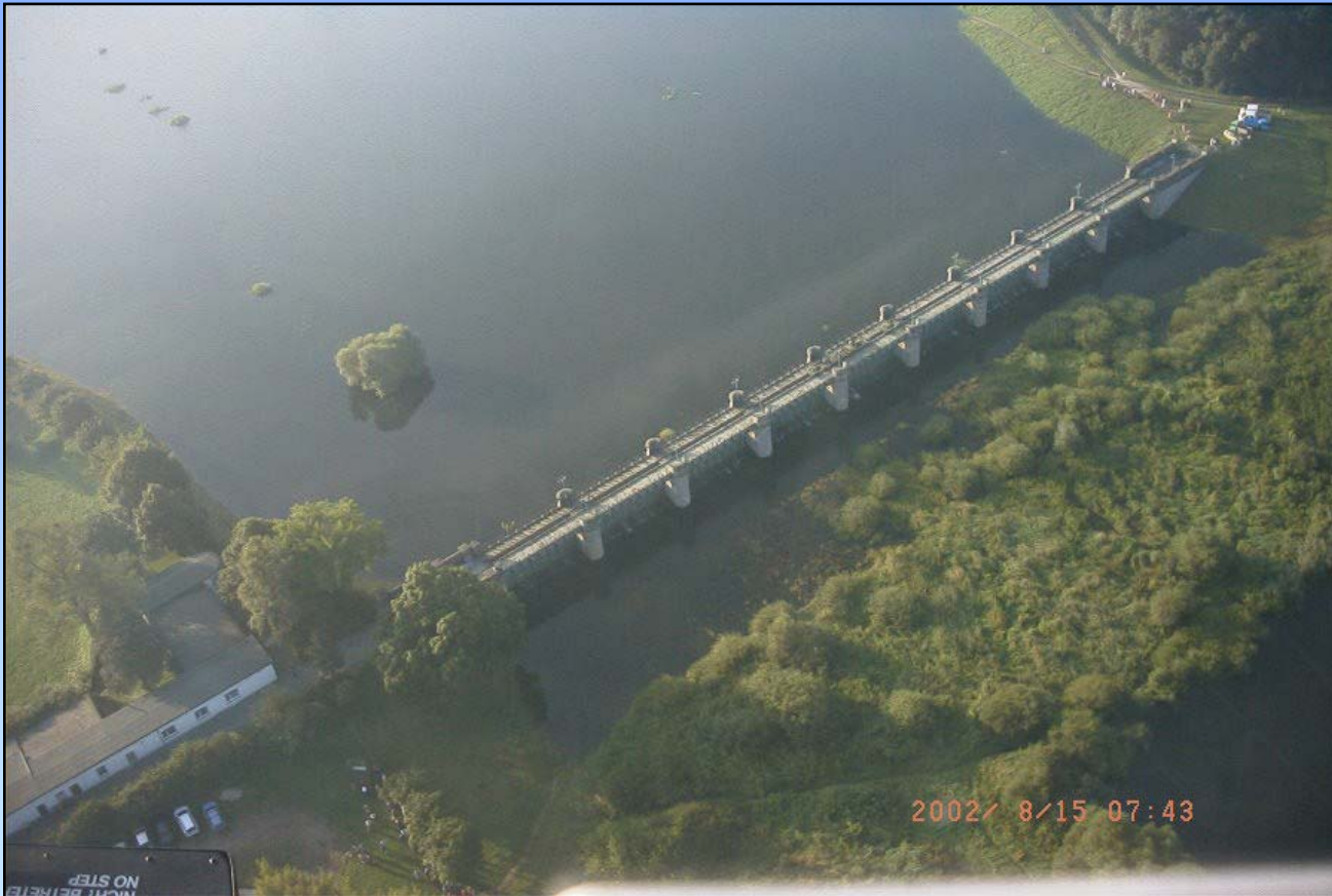
geöffnetes Pretziener Wehr im Umflutkanal Magdeburg beim HW 2002
