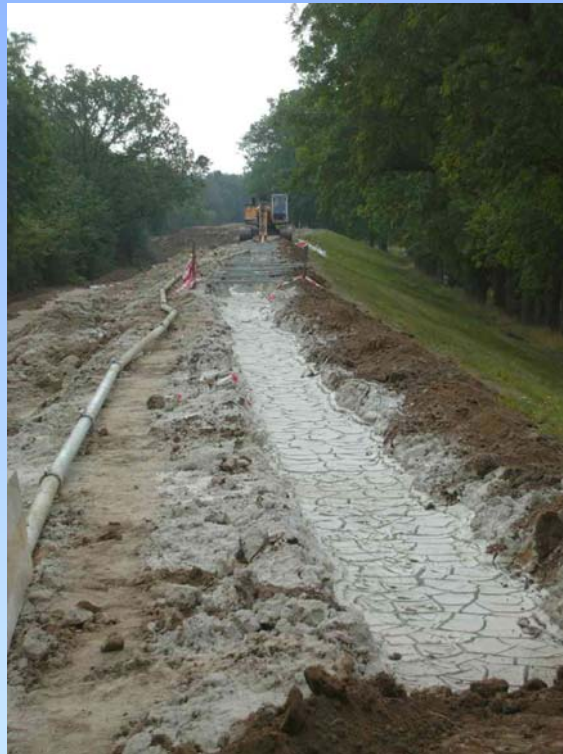
Bauphase des Suspensionsgrabens
