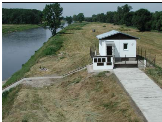
Měřicí stanice Zelčín po rekonstrukci v r. 2003 (Povodí Vltavy, s. p.)
