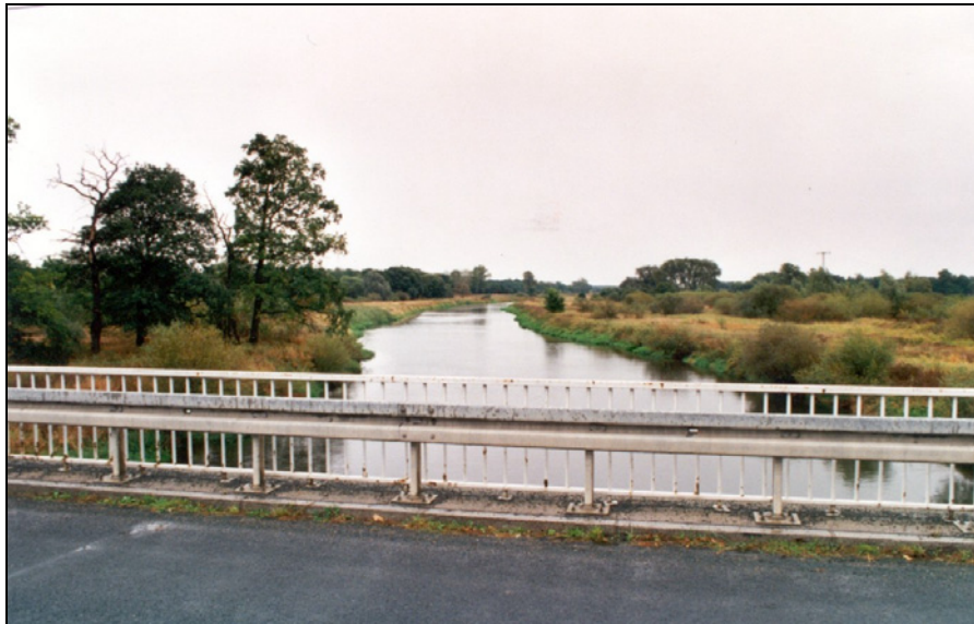
Schwarze Elster Brücke Gorsdorf -stromaufwärts-
