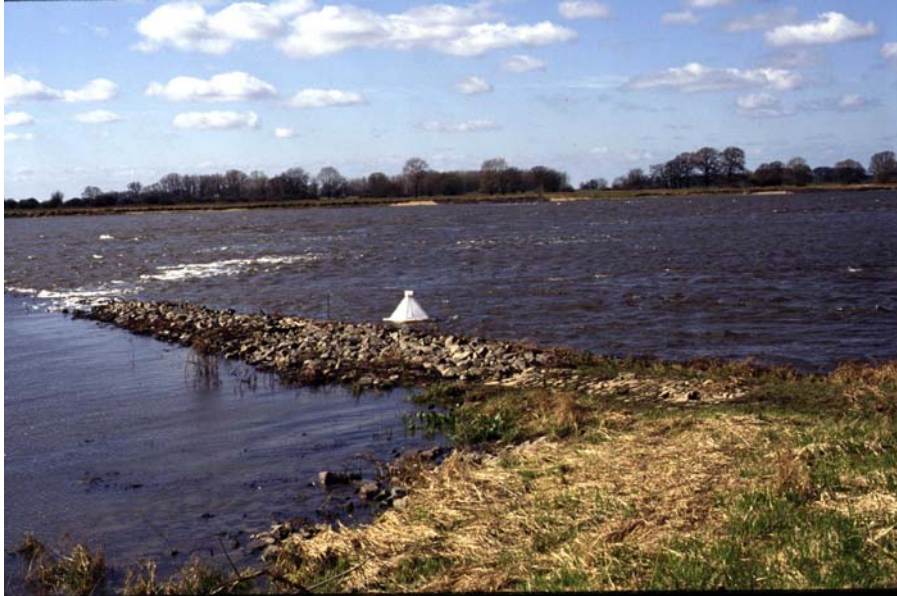
Abbildung 3: Buhnenfeld 3: Elbe-km 423,1 rechts Blickrichtung auf flußaufwärts gelegene Buhne, Eklektorstandort mitte; Niedrigwasser Hier finden wir ein geradezu "klassisches" Buhnenfeld. Die Buhnen wurden 1996 erneuert, d.h. mit einer neuen und auch zum Untersuchungszeitpunkt noch intakten Schüttung versehen. Hinter der stromauf gelegenen Buhne befindet sich ein mehrere Meter tiefer Kolk. Die Substrate sind im oberen, ufernahen Teil schlammig, weiter unterhalb feinsandig bis sandig. Aufgrund der Topographie fallen bei Niedrigwasser weniger grosse Flächen trocken, die Auflauhöhen von Wellen sind gering.
