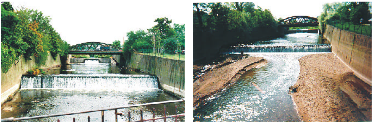
Abb. 6: Mündungsprofil der Weißeritz (Dresden-Friedrichstadt) am 30.09.1999 (li) und am 27.04.2000 (re) nach abgelaufenem Elbehochwasser und erfolgter Sedimentdepotbildung von ca. 2700 m 3 im Zeitraum 02 bis 04/2000.
