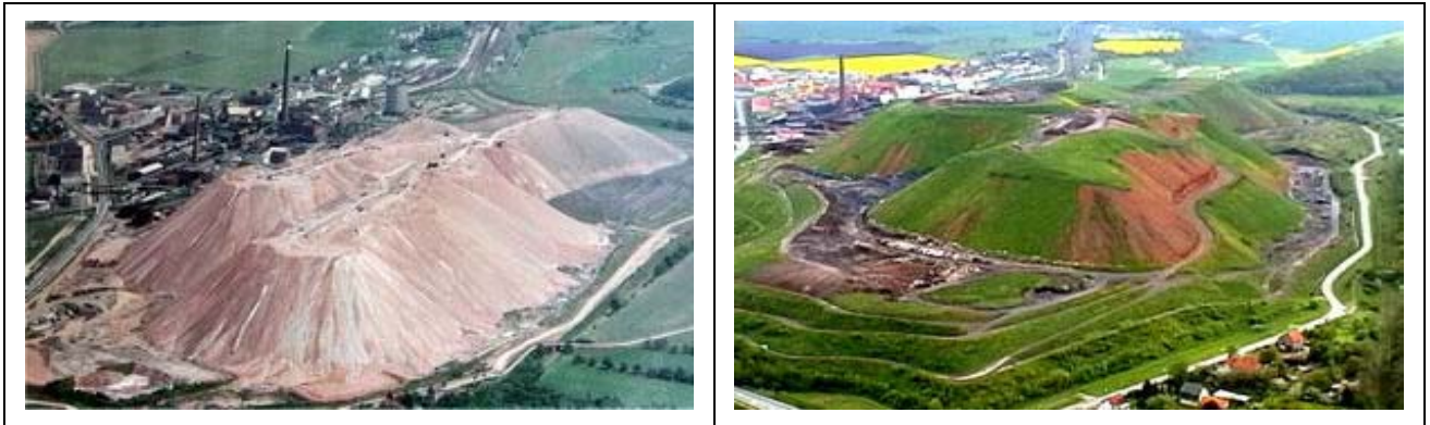
Abbildung 48: Haldenabdeckung – Beispiel Halde Bleicherode 1990 & 2002 (Abdeckungsgrad ca. 40%)
