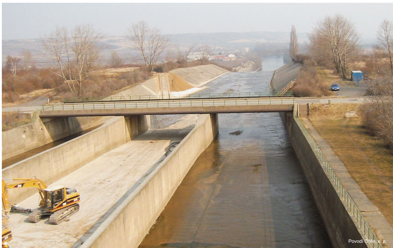
Obr. 3.1-1: Bezpečnostní přeliv VD Nechanice na Ohři
