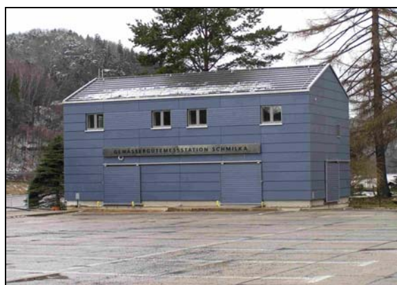
Schmilka/Hřensko, neu aufgebaute Wassergütemessstation 2004 (Staatliche Umweltbetriebsgesellschaft Neusörnewitz)
